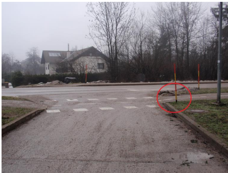
Slika 30: Križišče stranske ceste in izvoz na kolesarsko stezo brez prometnega znaka
