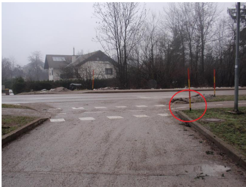
Slika 43 Križišče stranske ceste in izvoz na kolesarsko stezo brez prometnega znaka.
